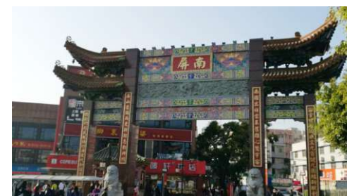
南屏牌坊修復前
